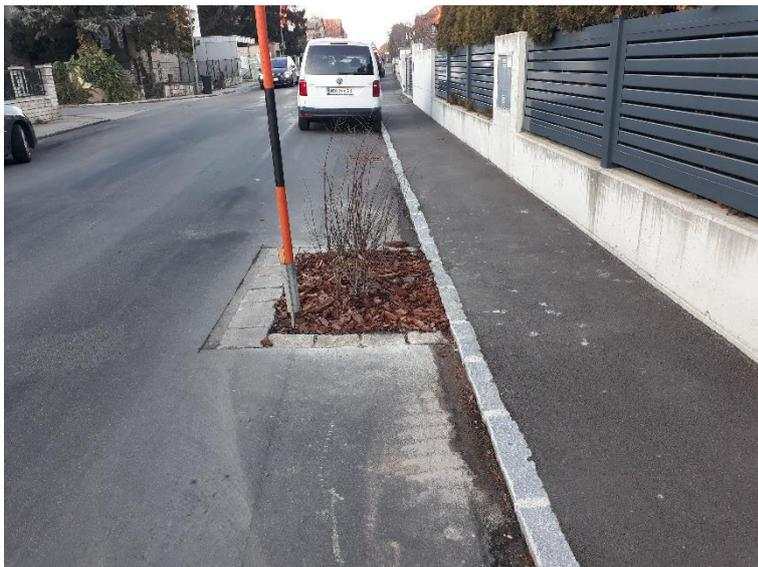
Abb.36 keine ausreichenden Abmessungen einer Baumscheibe – Rembrandtgasse (Stand: 12.2019)
